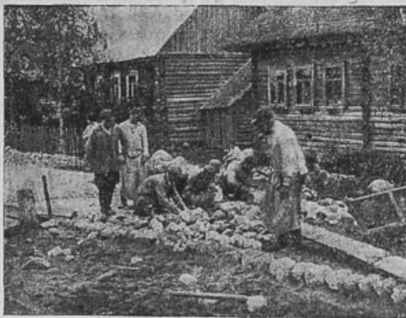
На дорожных работах
